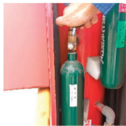
②加圧用ガス容器のバルブを全開にする *反時計回り(左回転)
